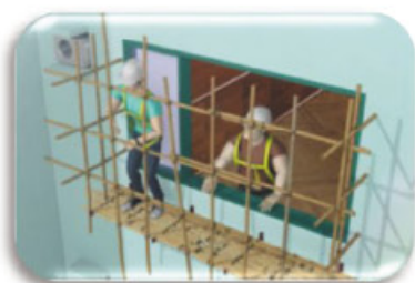
1. 懸空式竹棚架拆卸篇
