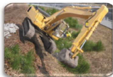
4. 挖掘機的安全操作
