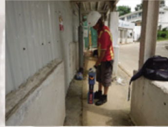
CCTV survey for conduits
